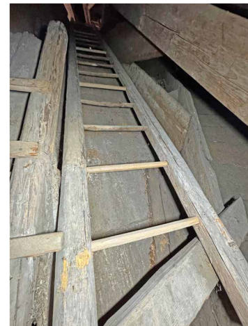
Aufstiegsleiter zum Dachstock des Oktogons mit erneuerten Sprossen
